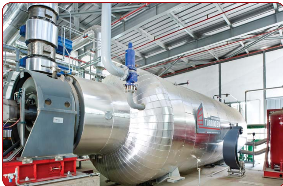
Цементный завод мощностью 2 МВт
